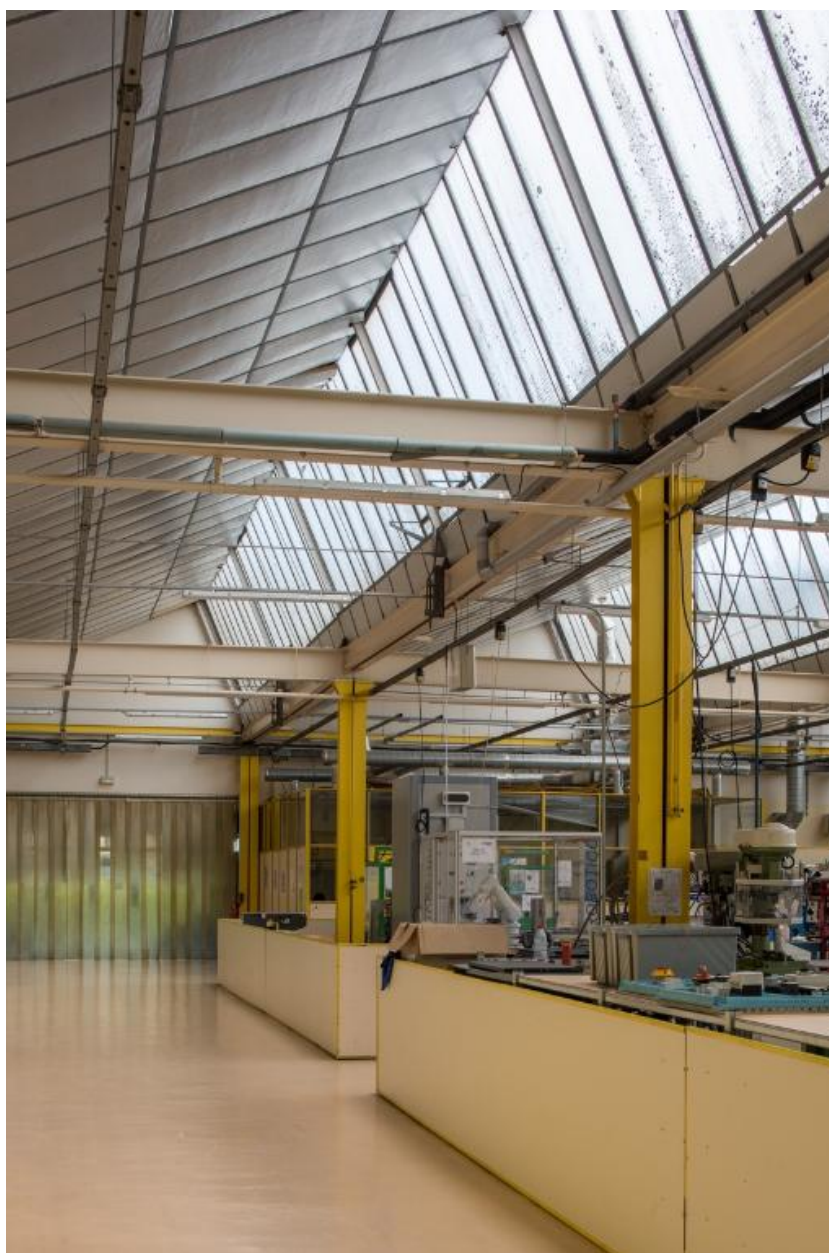
Bâtiment G, ateliers : structure métallique et sheds.
