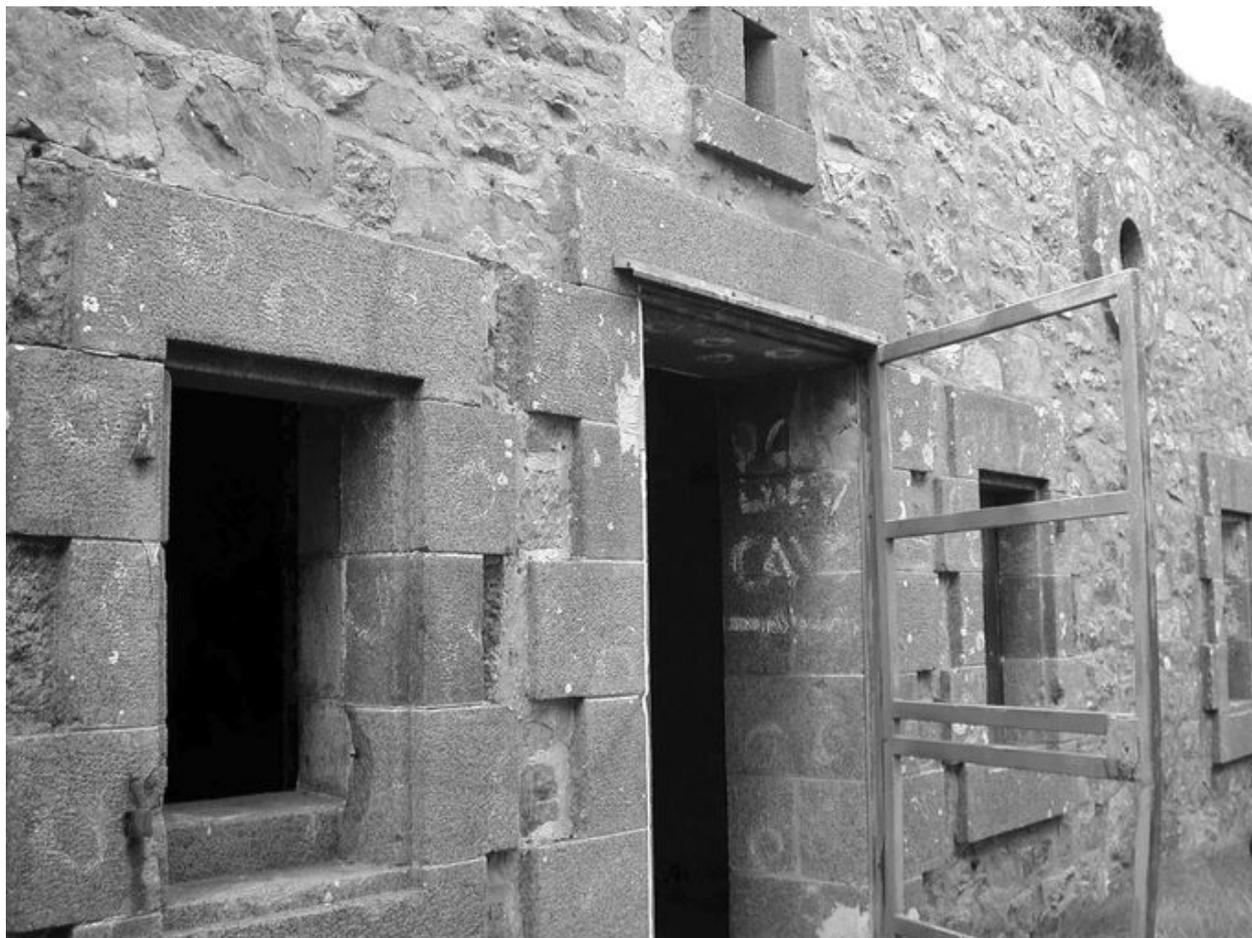
Vue de l'extrémité de la batterie de mortier : abri double sous traverse en maçonnerie
