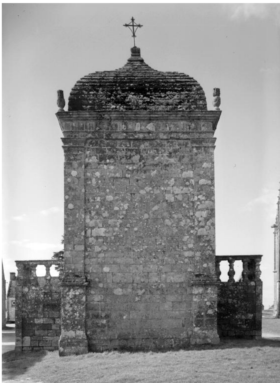
Scala, vue d'ensemble de la face est.
