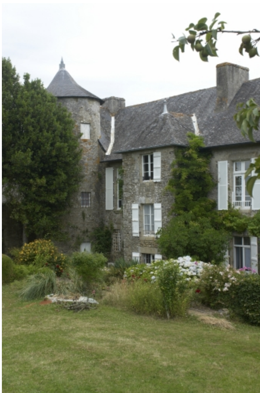
Logis, élévation sud, détail
