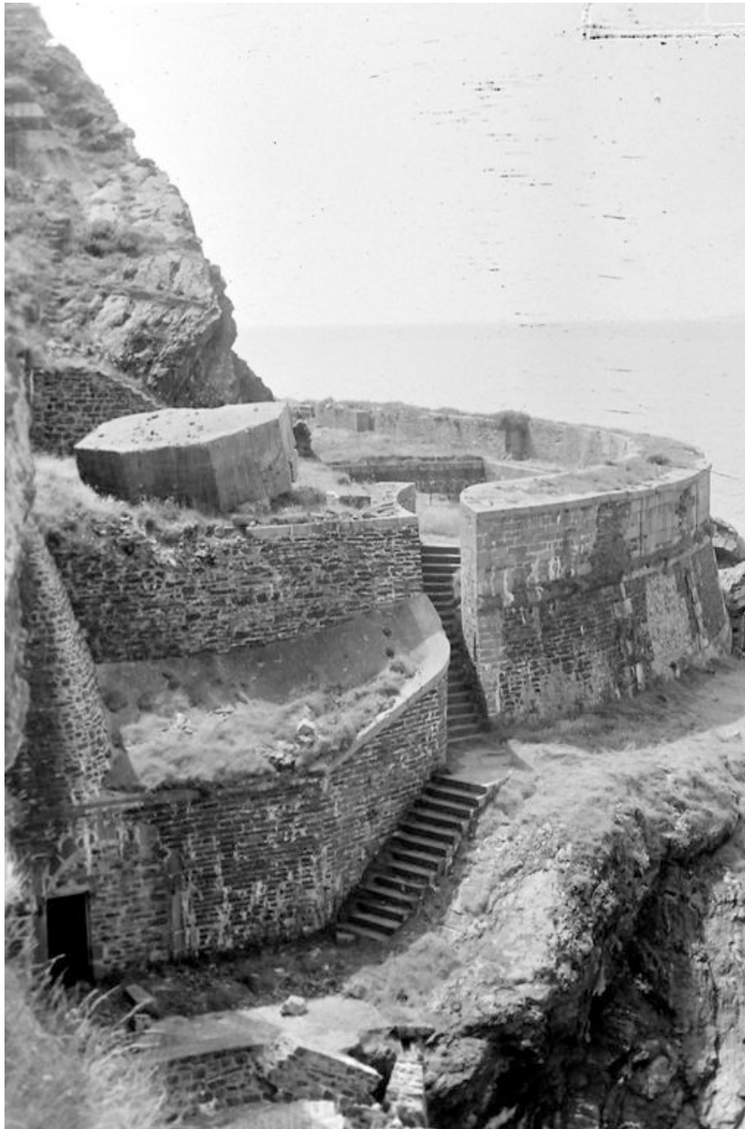
Vue générale de la batterie de Cornouaille en 1967 : extrémité est depuis la batterie de Beaufort
