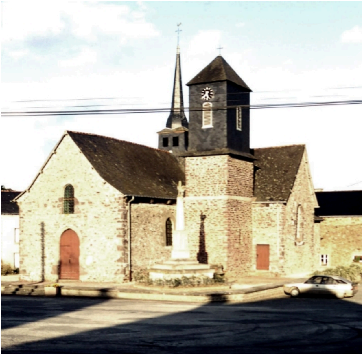
Vue générale prise du sud ouest.
