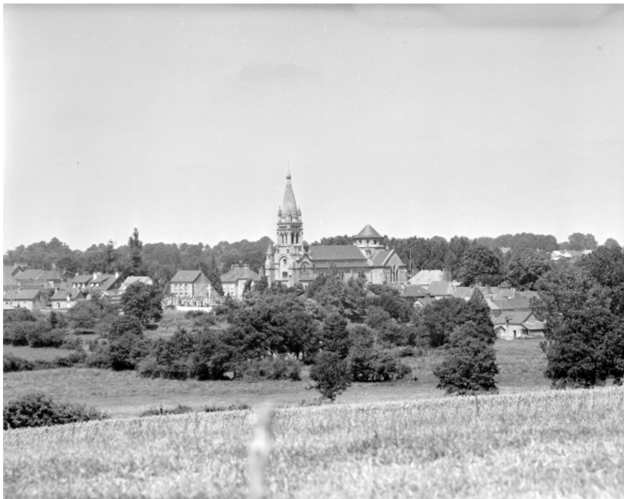
Vue de situation prise du sud-est.
