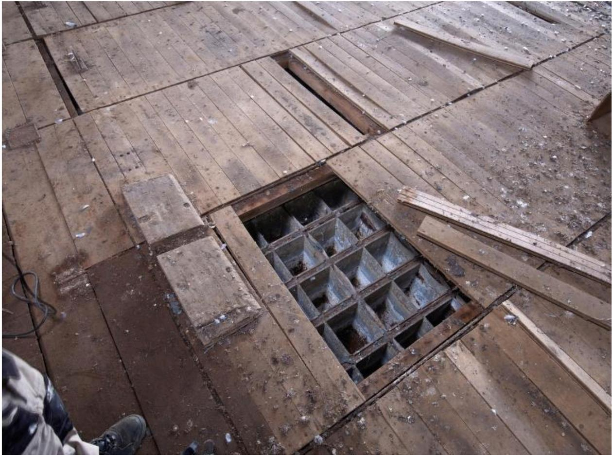
Frigorifique de Lorient : 4e étage, rames de mouleaux sous plancher : remplis d'eau douce réfrigérée à -10°C
