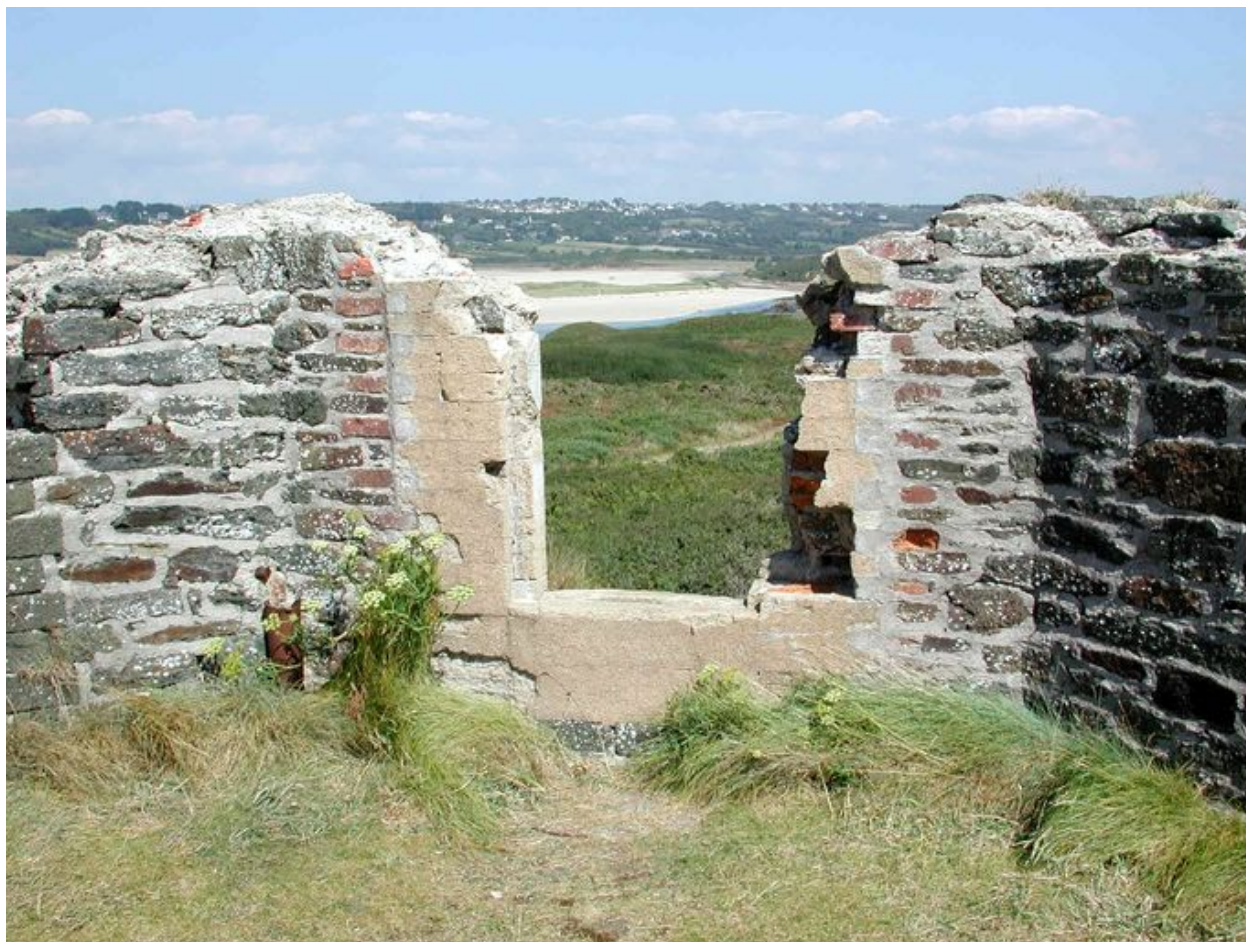
Vue du réduit de batterie de côte de l'île de l'Aber : terrasse, parapet percé d'embrasures et de créneaux de fusillade
