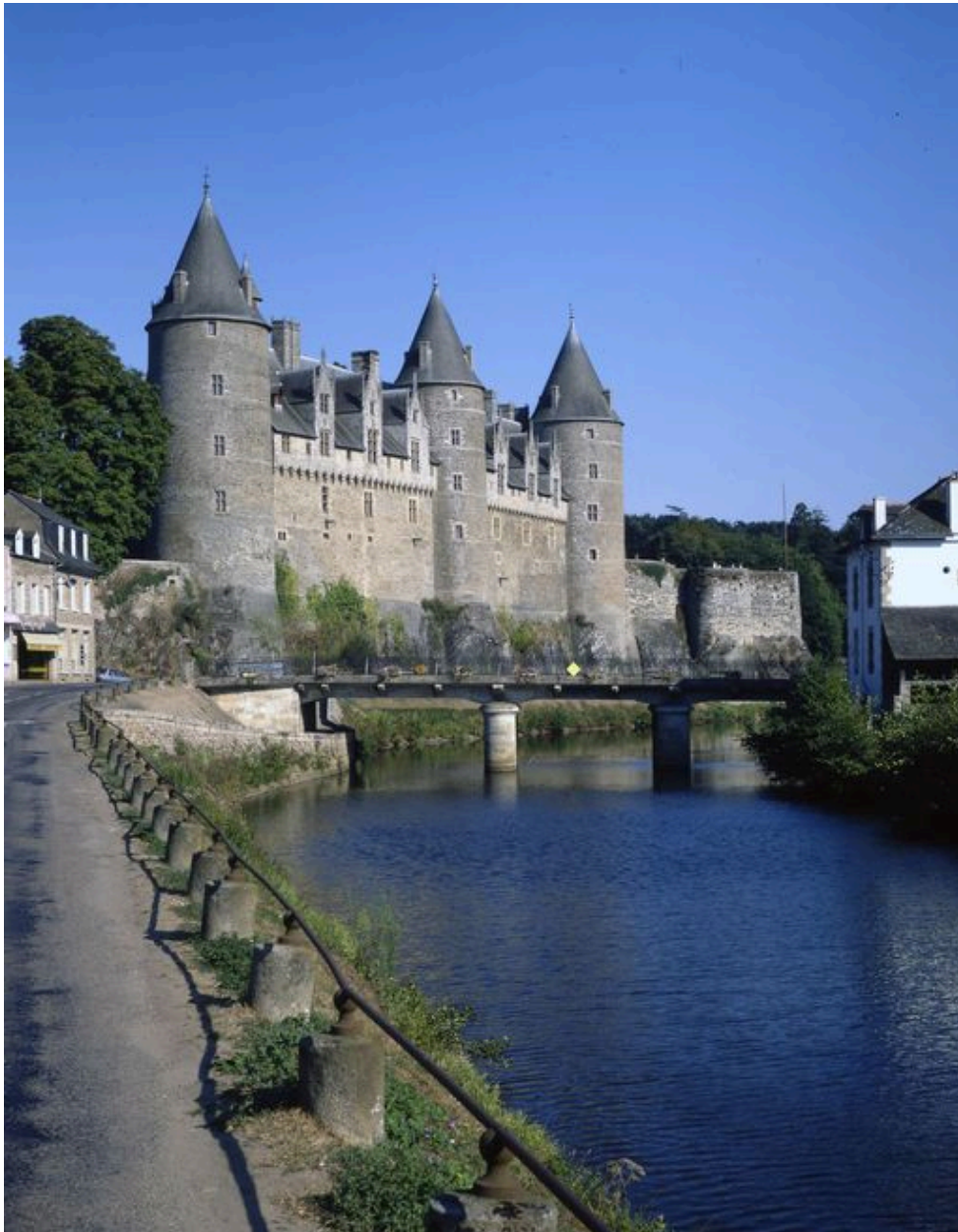
Elévation sur rivière : vue générale prise de l'ouest
