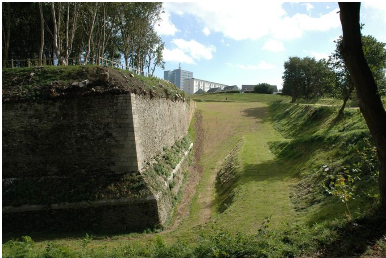
Vue de l'ouvrage à cornes de Quéliverzan
