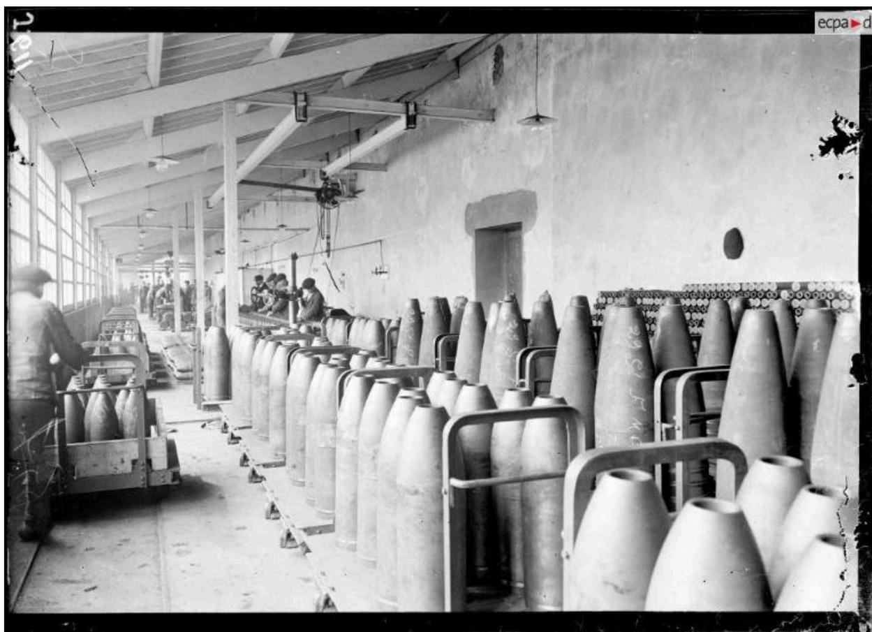
Vue intérieure d'un atelier en 1916 : préparation des obus de gros calibre. Ce long atelier couvert en appentis et éclairé par des fenêtres de type verrière est traversé par une voie ferrée étroite
