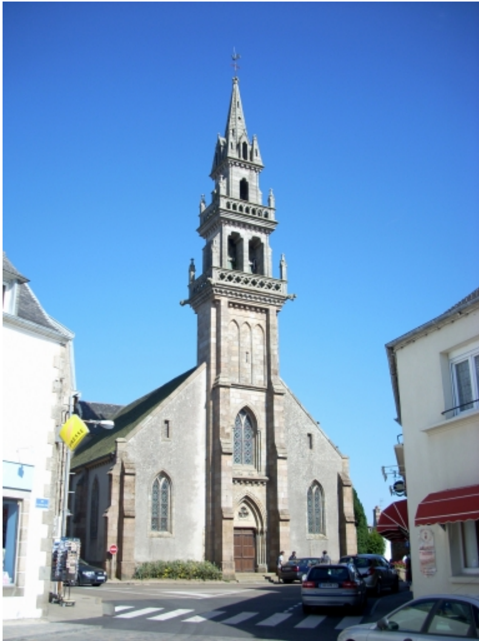
Carantec, église paroissiale Saint-Carantec : vue générale ouest
