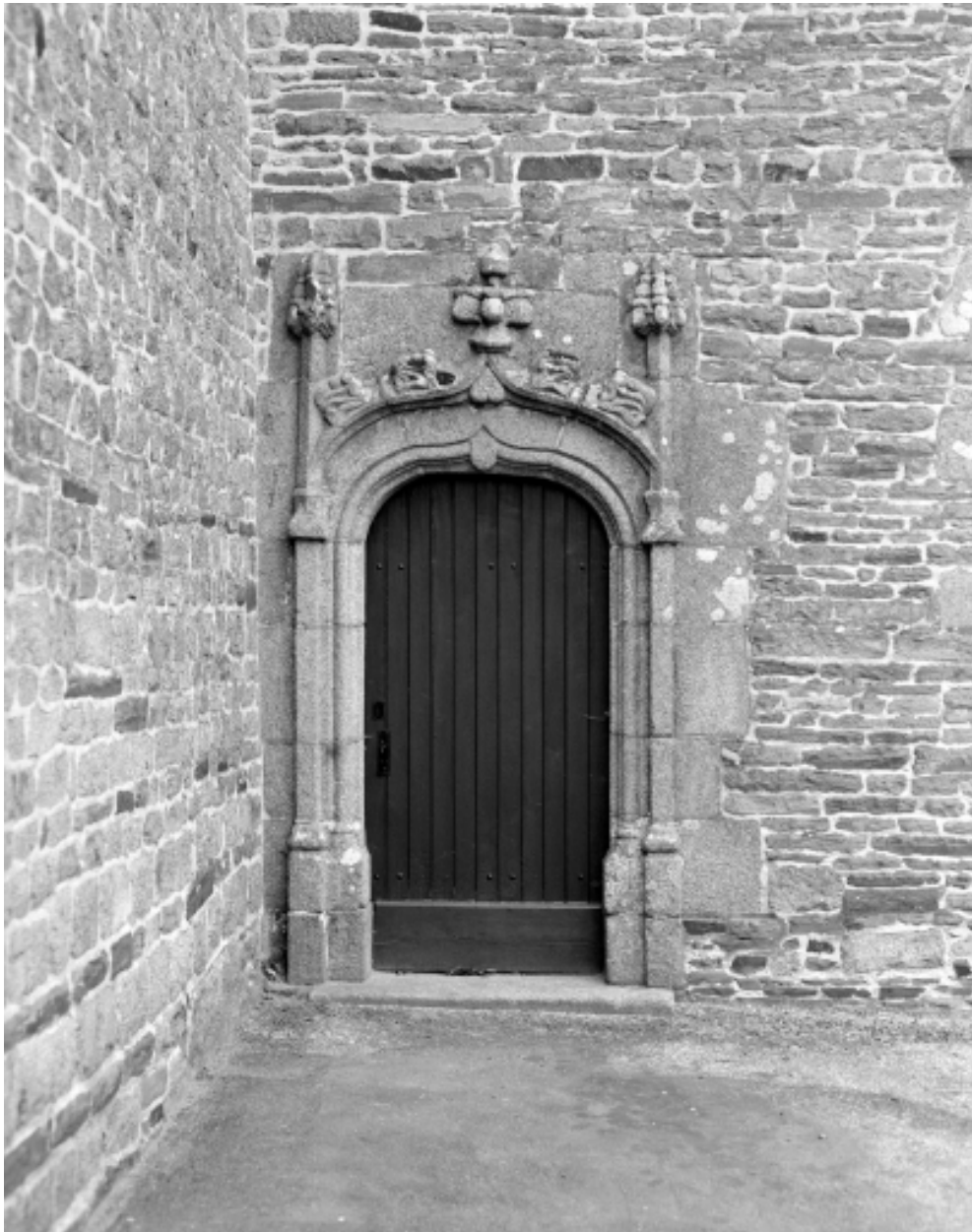
Elévation Sud, porte Est : vue générale
