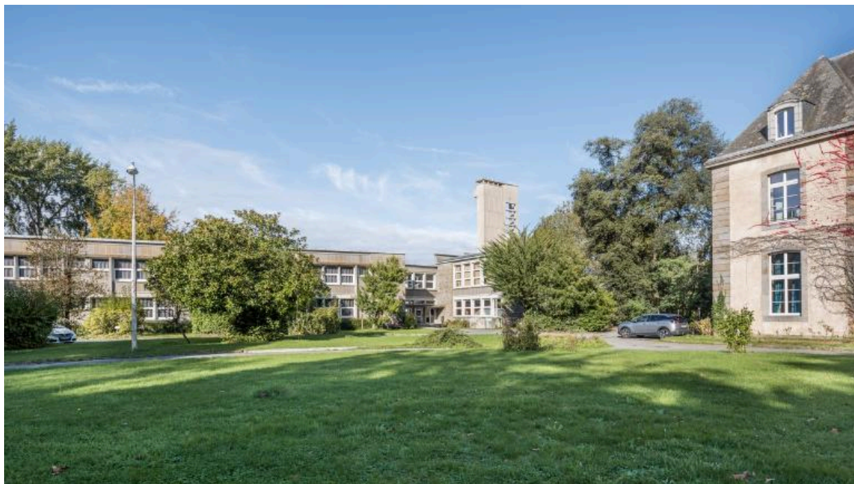
Vue d'ensemble : façade sud de l'externat B1 (Louis Arretche, architecte) et façade ouest de la Malouinière de la Balue.
