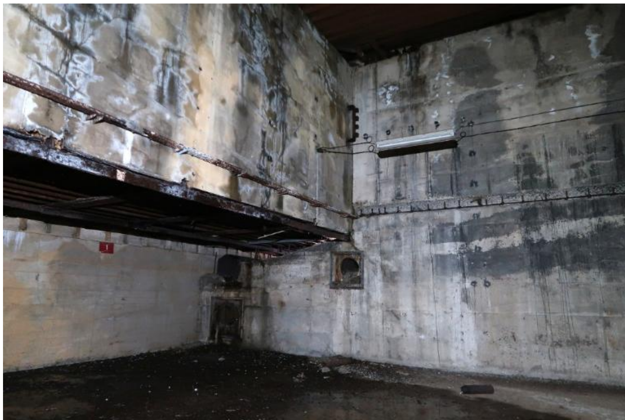
Vue de l'extension nord-ouest : extrémité sud du troisième étage
