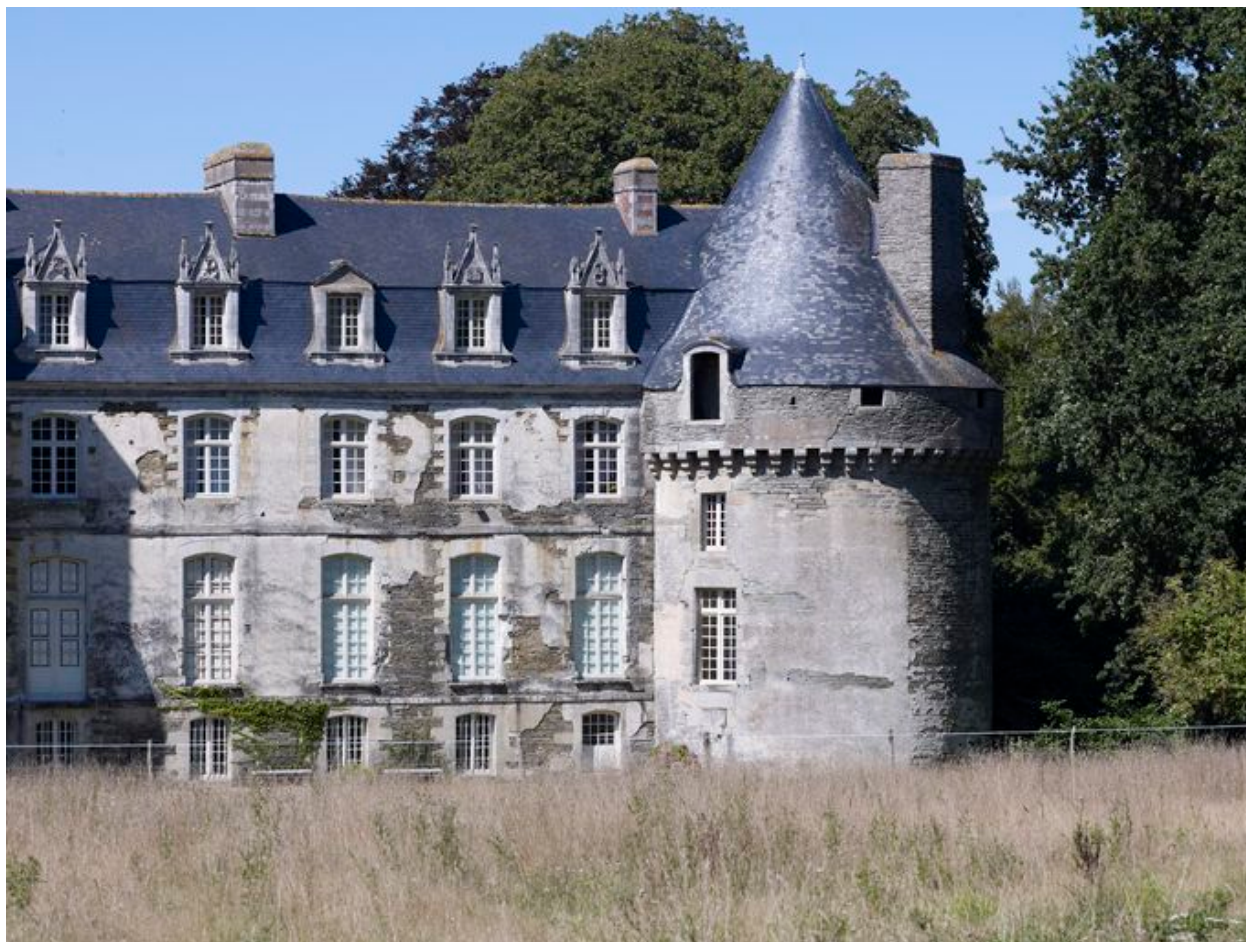
Château, logis, élévation sud partie est, avec la tour (état en 2010)
