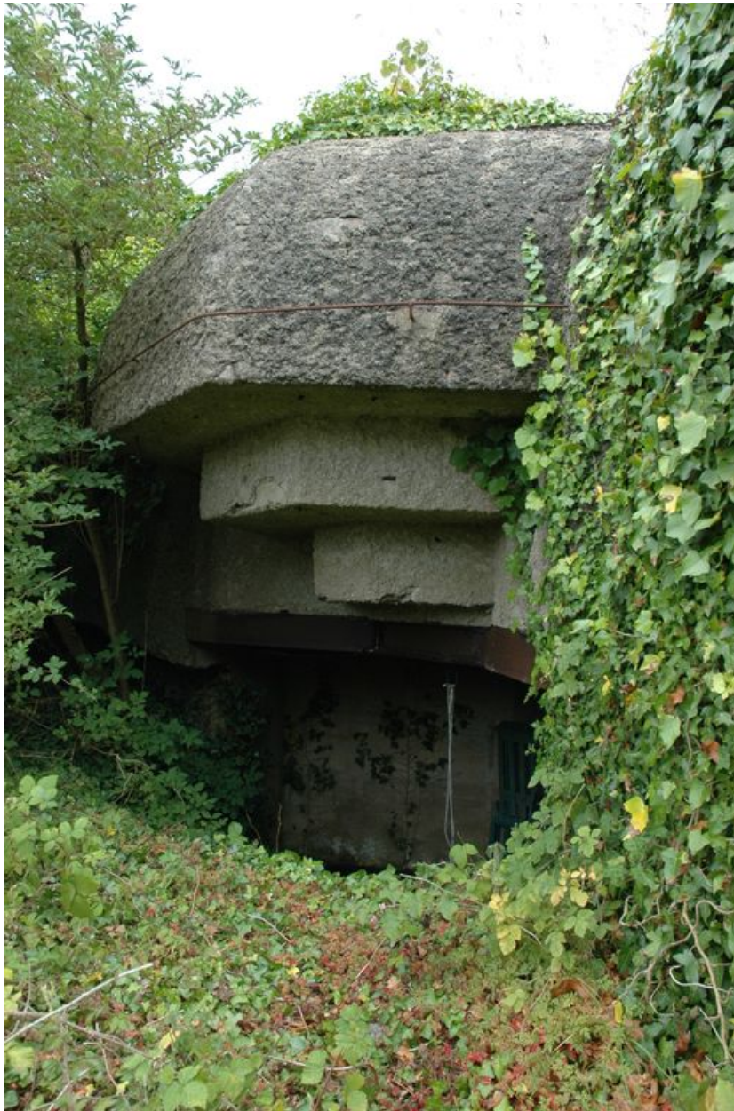
Vue de l'un des quatre bunkers-casemates de type 671 : embrasure frontale à redan (état en 2008)
