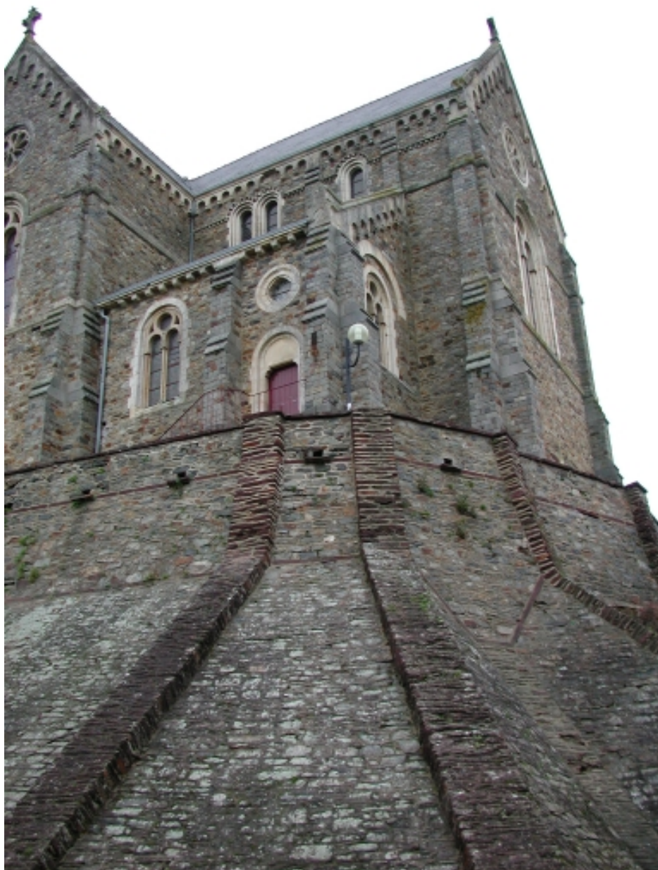
Murs de soutènement
