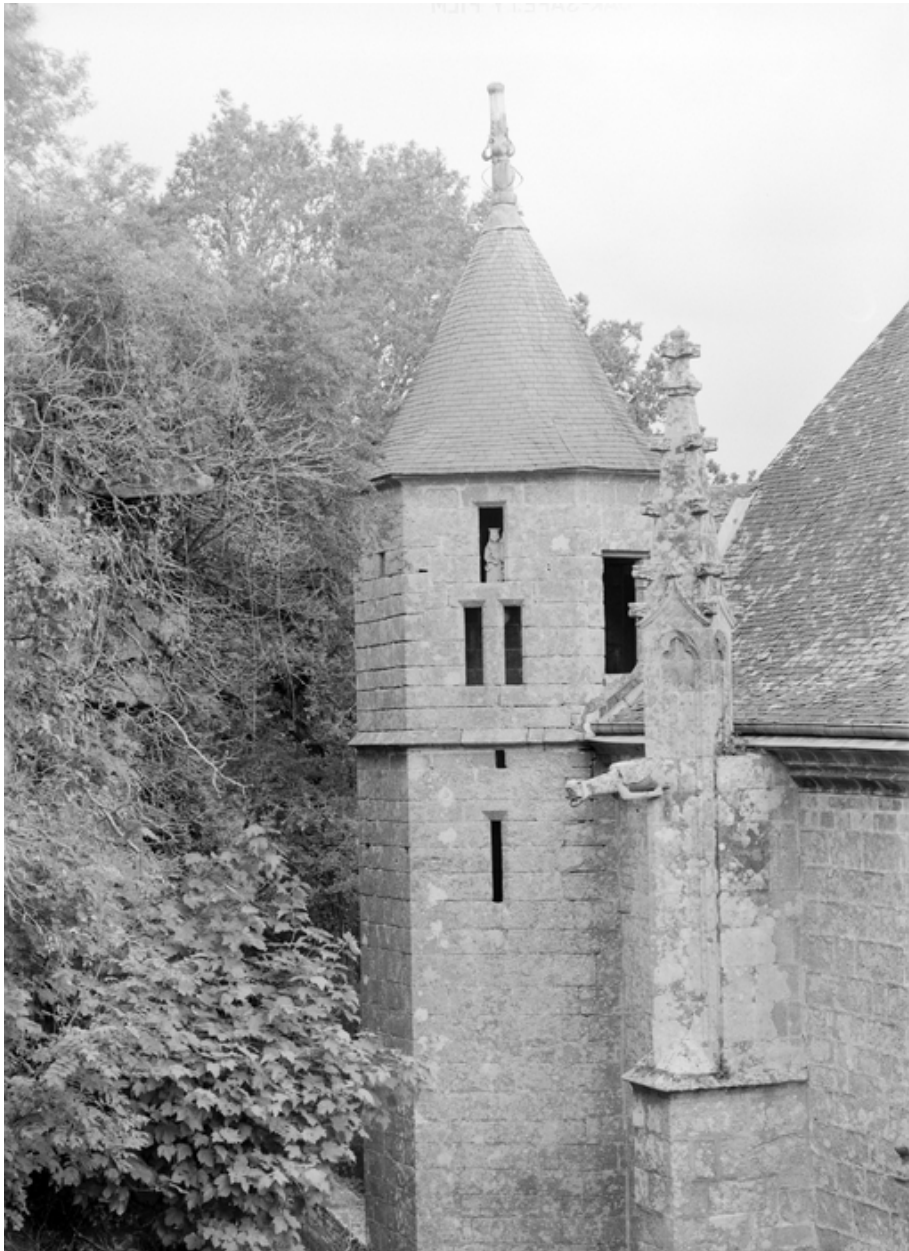
Tourelle d'escalier nord-ouest.
