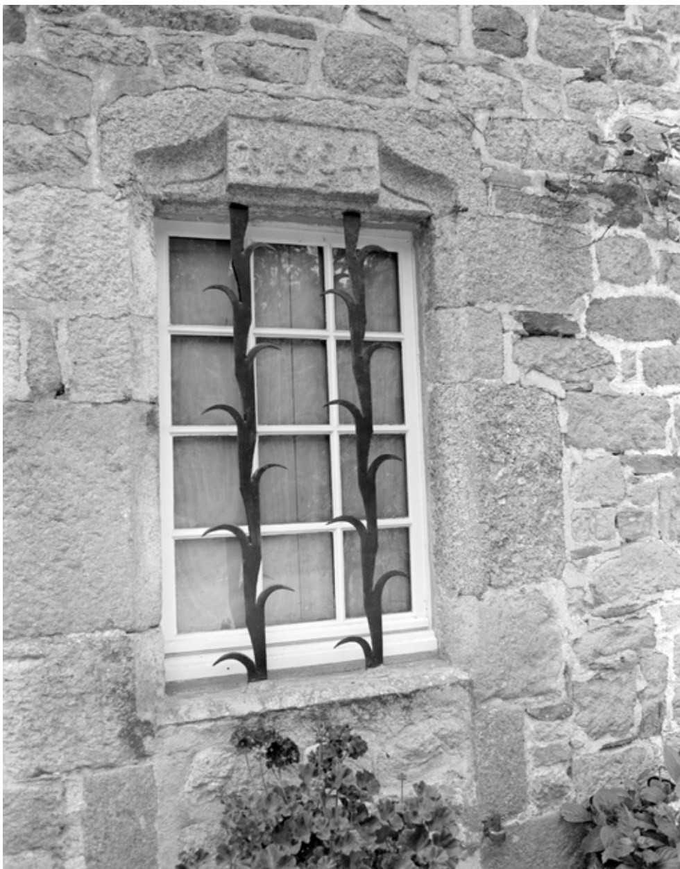
Façade antérieure : fenêtre du premier niveau, datée 1664
