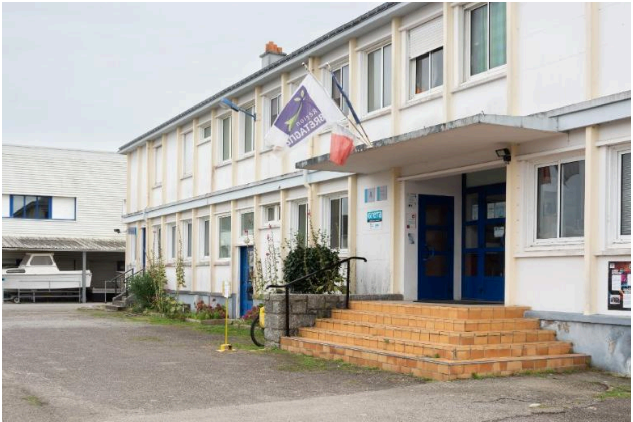
Façade nord de l'administration. Yves Guillou et Georges Tourry, architectes, 1959.
