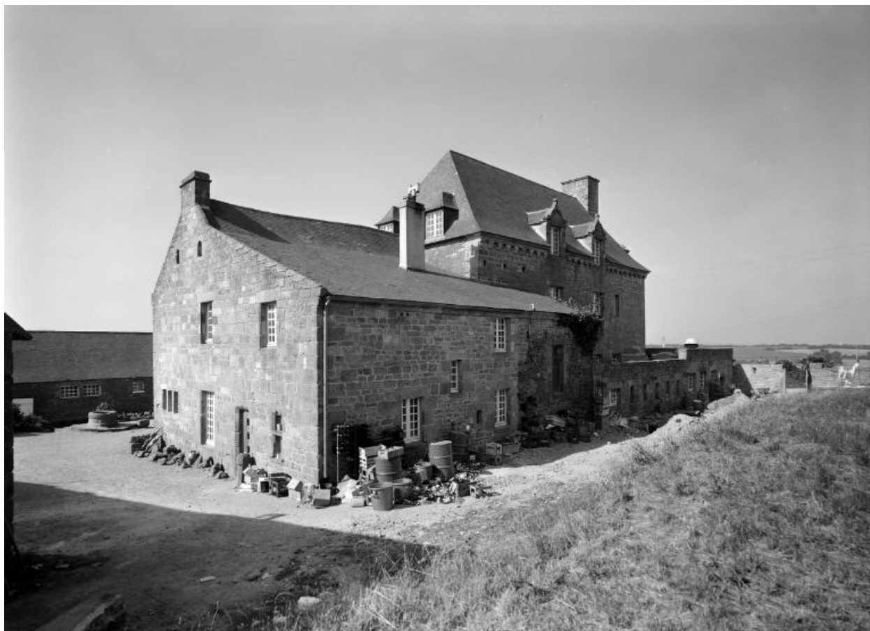
Vue de situation prise du nord-est
