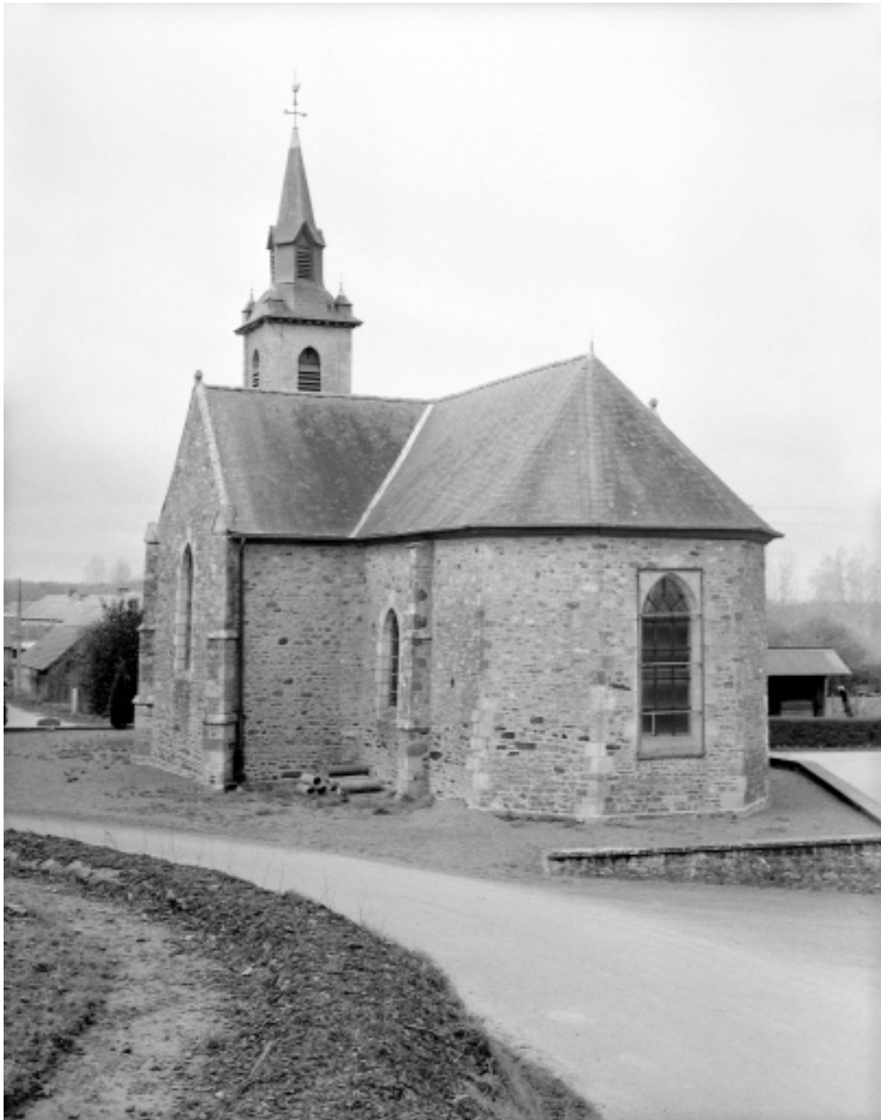
Etat en 1994, élévation Est : vue générale
