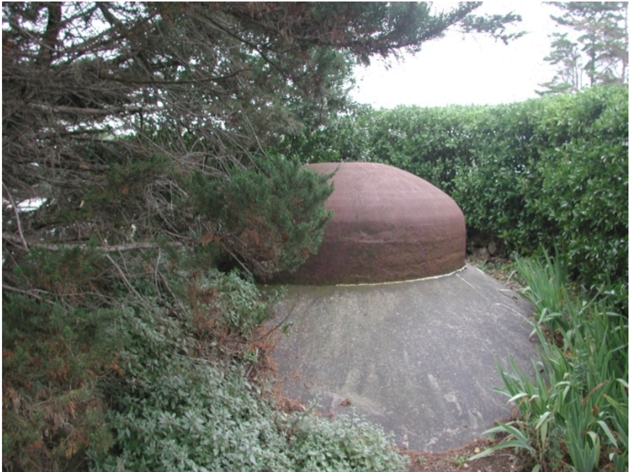
Tourelle blindée de 20 cm d'épaisseur pour protéger le périscopes de Château-Tanguy
