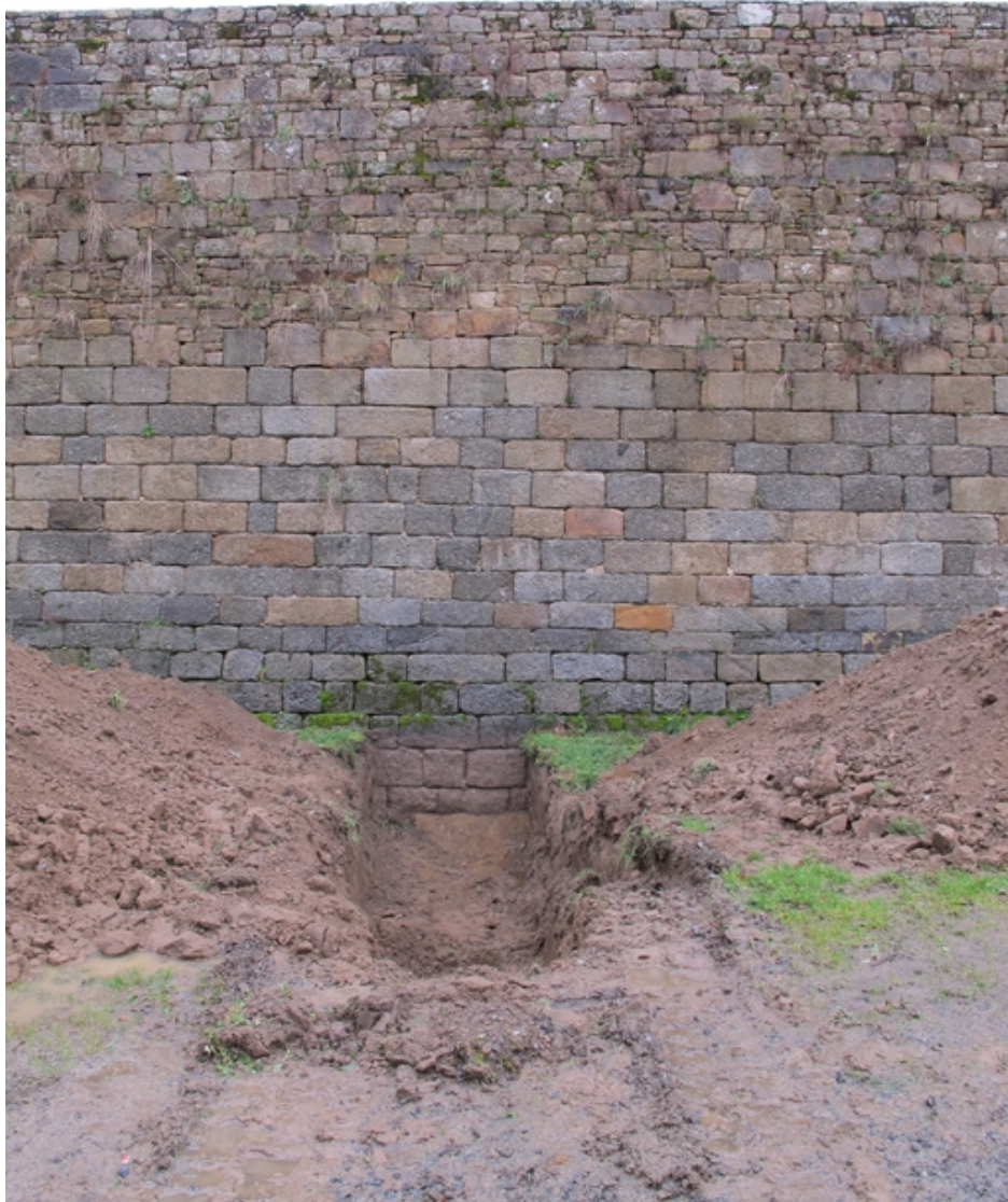
Vue des sondages archéologiques au pied de la courtine de la basse-cour (Service régional de l'archéologie, Yves Roumegoux, 16 février 2011)
