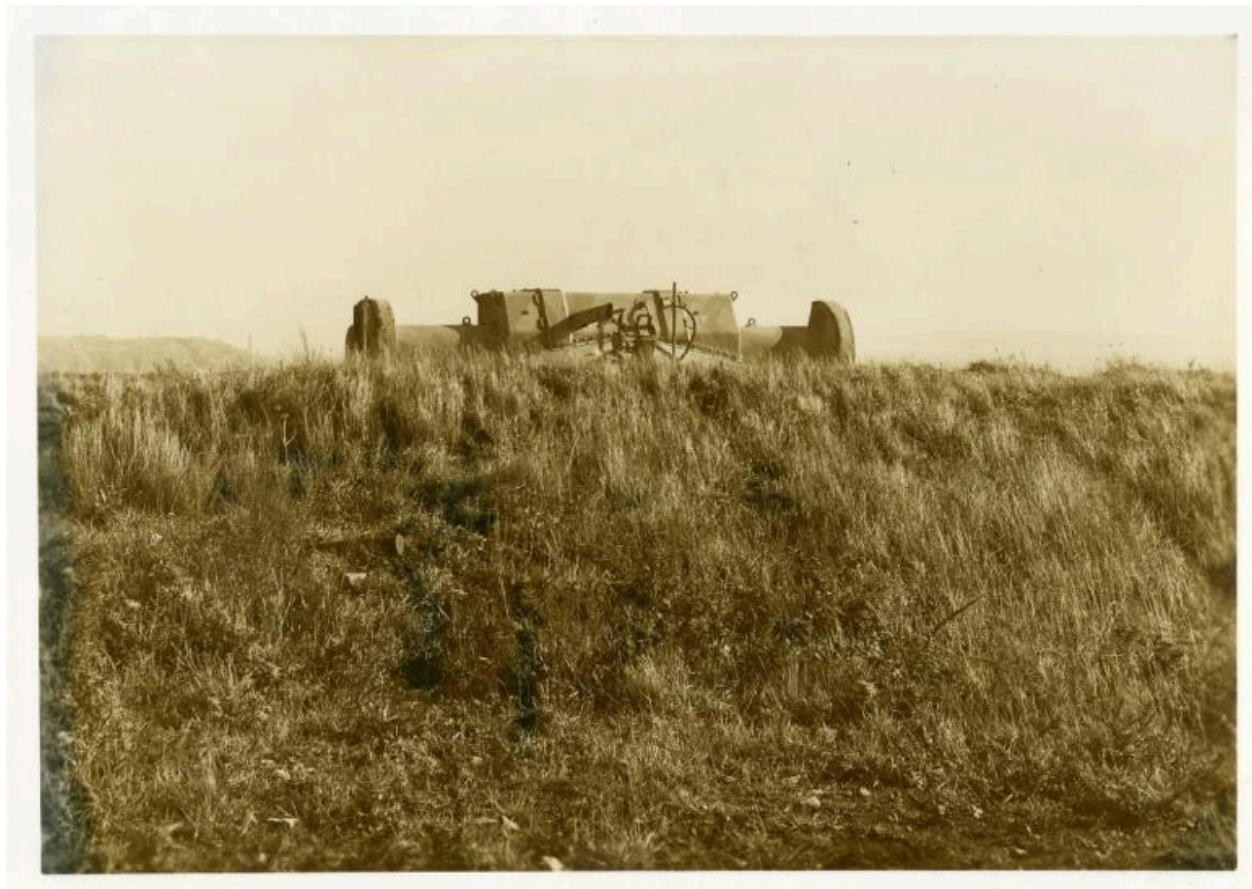
Vue du télémètre blindé du bunker-poste de direction de tir (Archives municipales de Brest : 2Fi12645 ; photographie similaire dans le Rapport Pinczon du Sel, 1946-1949)
