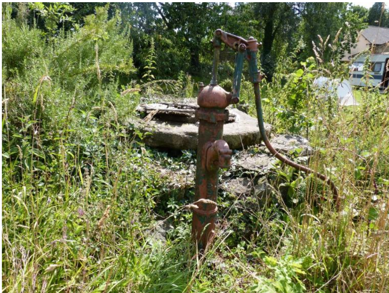
Puits et pompe à eau
