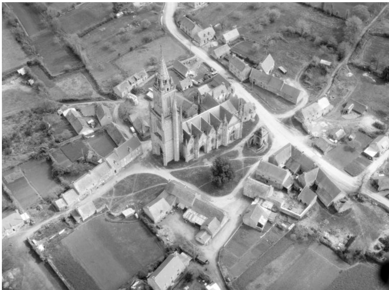
Vue générale prise du sud-ouest.
