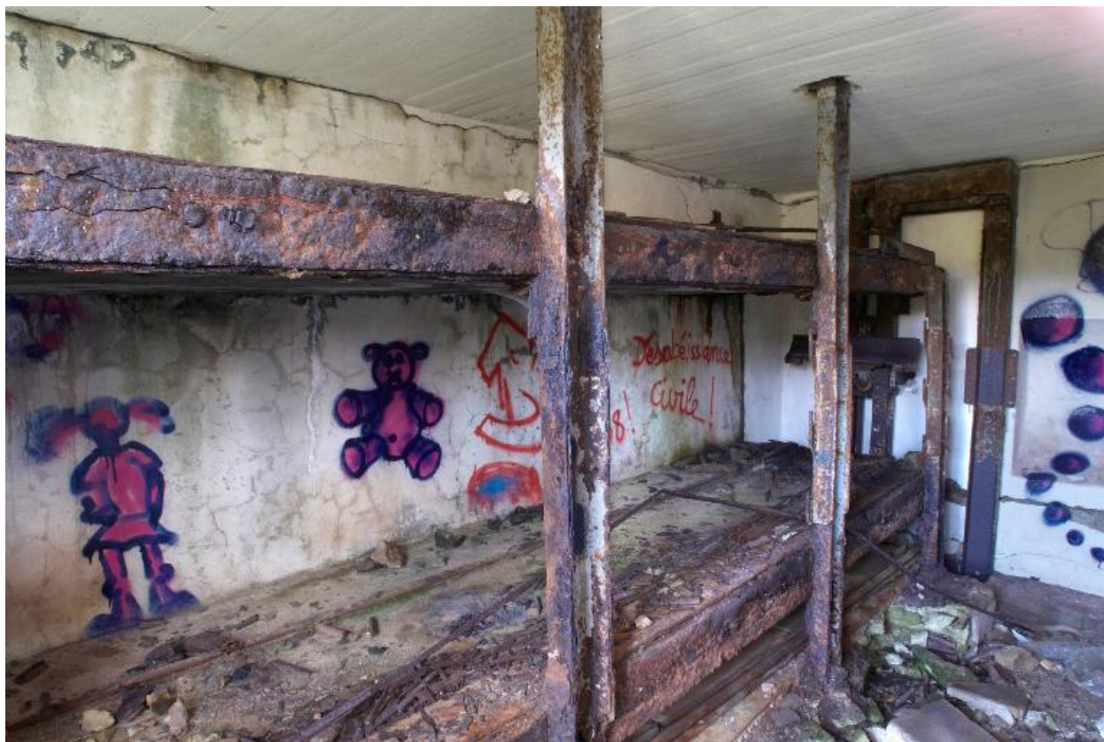
Vue intérieure de l'un des magasins de combat : étagère et monte-obus dans un compartiment à projectiles (état en 2009)
