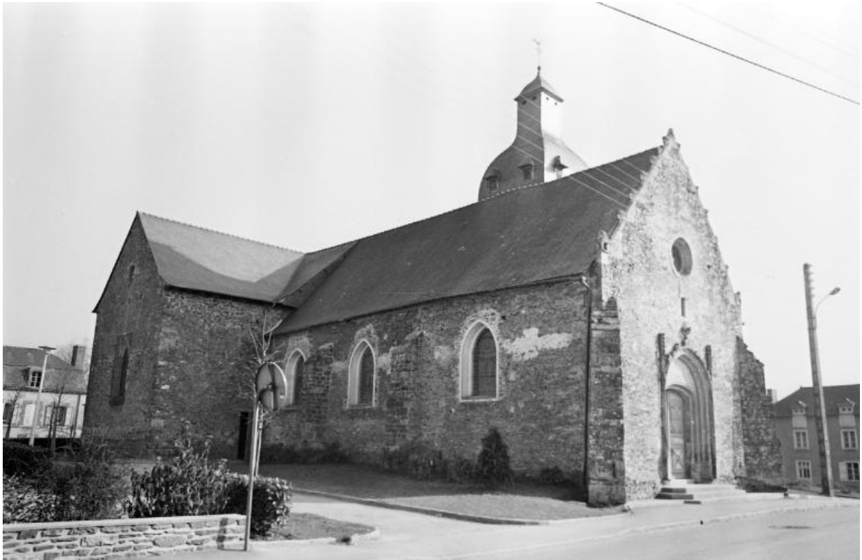
Elévation nord, état en 1972
