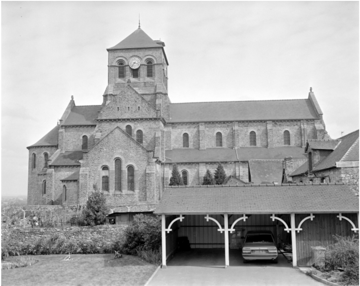
Elévation Ouest : vue générale
