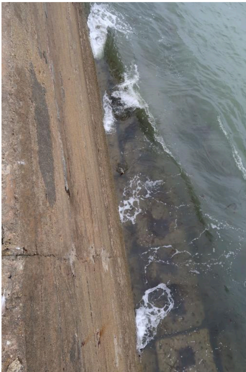
Môle, blocs placés en risberme
