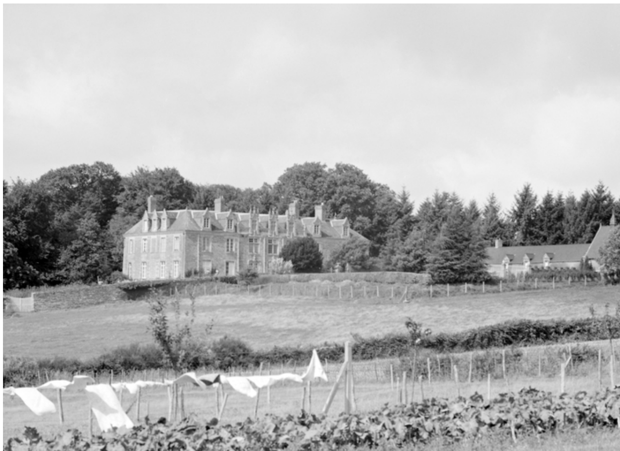
Vue de situation prise du sud-est
