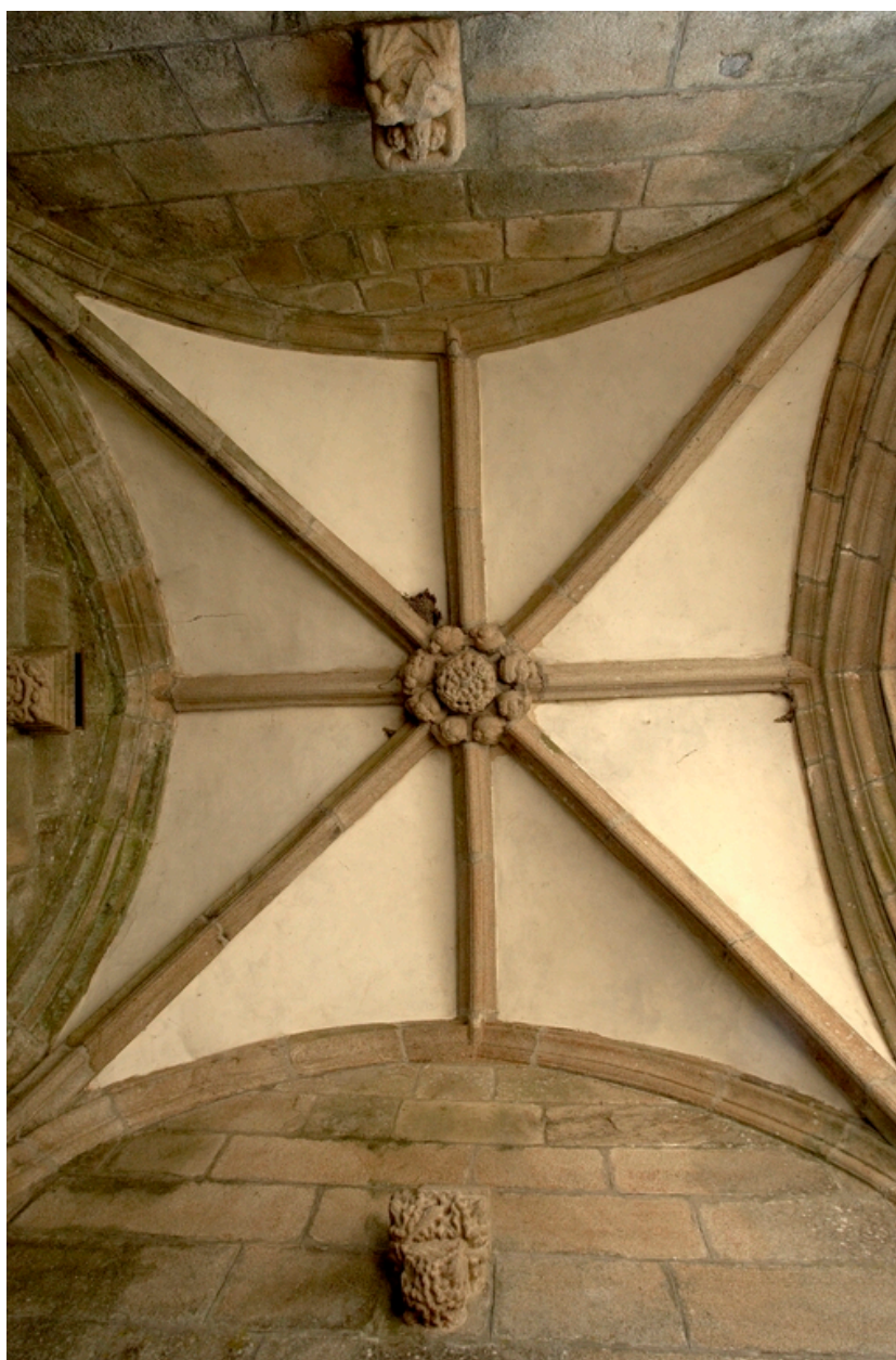
Porche sud, vue générale de la voûte
