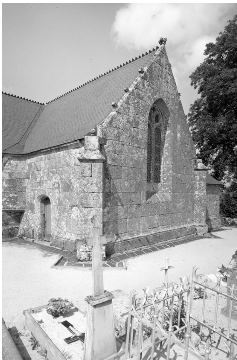
Croisillon sud : élévation ouest et sud
