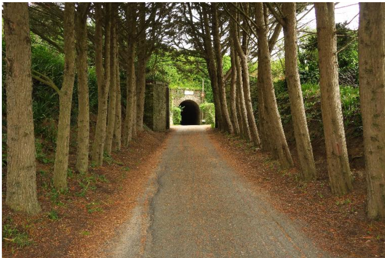
Groix, fort dit Fort Surville, tunnel du ravelin depuis l'extérieur.
