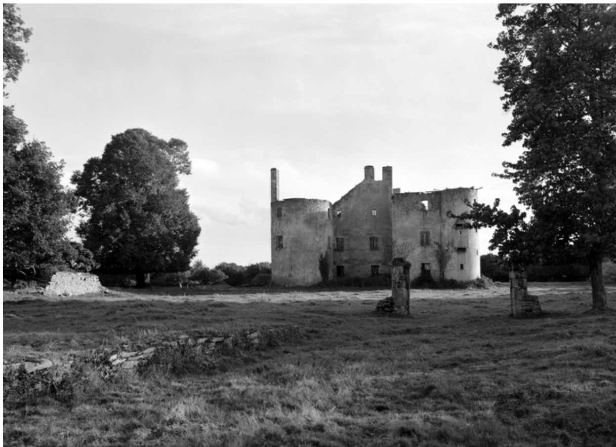
Vue générale prise du nord.
