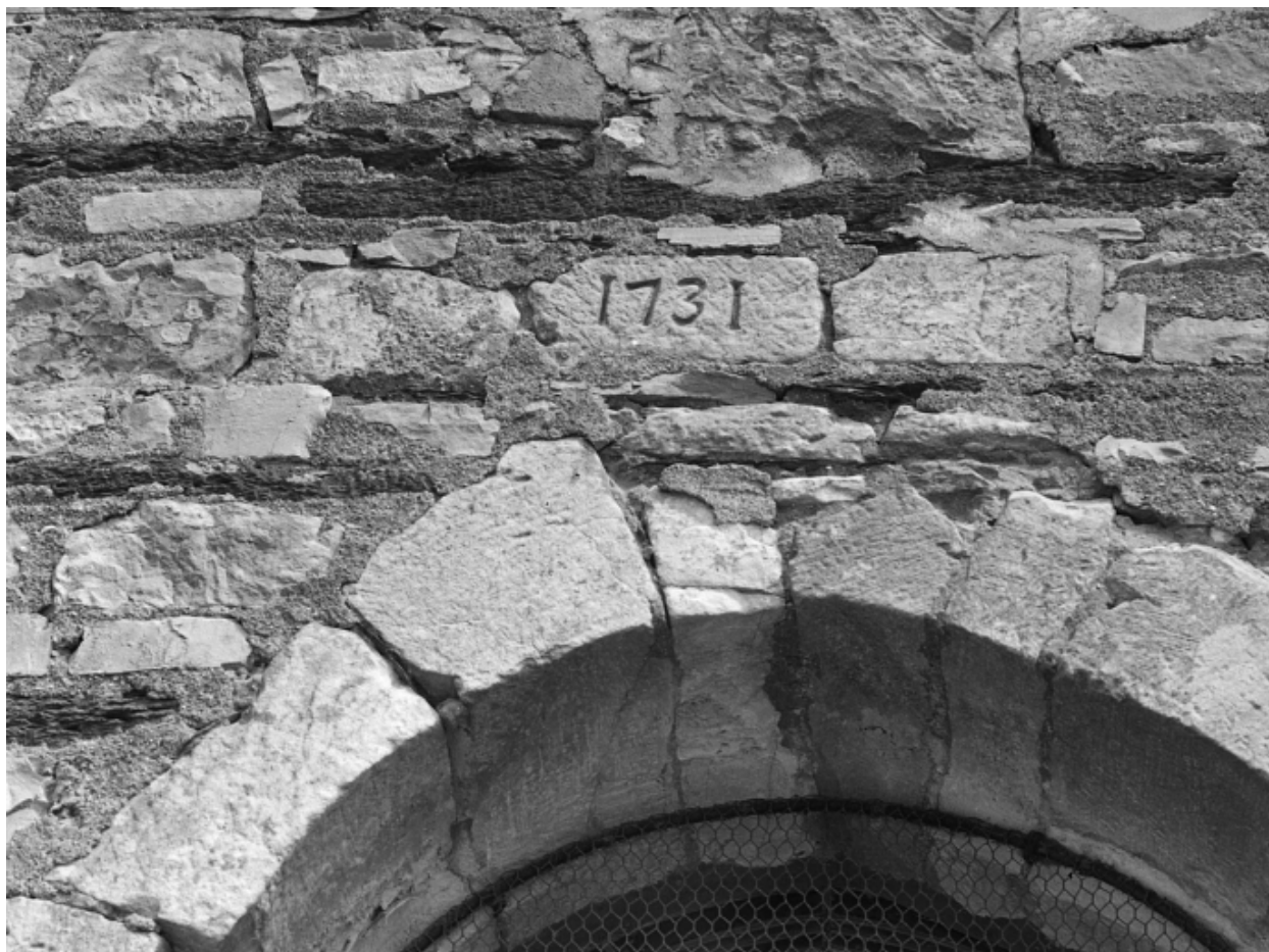
Détail de la date 1731 sur la troisième travée.
