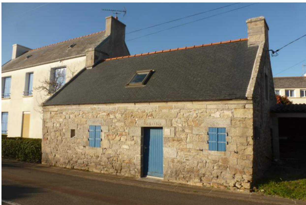
Maison 4, élévation antérieure du logis daté 1821.
