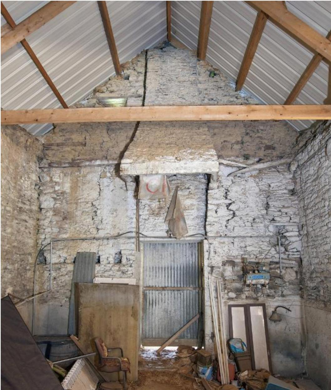
Remise nord-ouest. Pignon nord. Vue intérieure avec les traces des différents niveaux : cheminée de l'étage en surcroît, emplacements des embouts de poutres du plancher, sablière du plafond.
