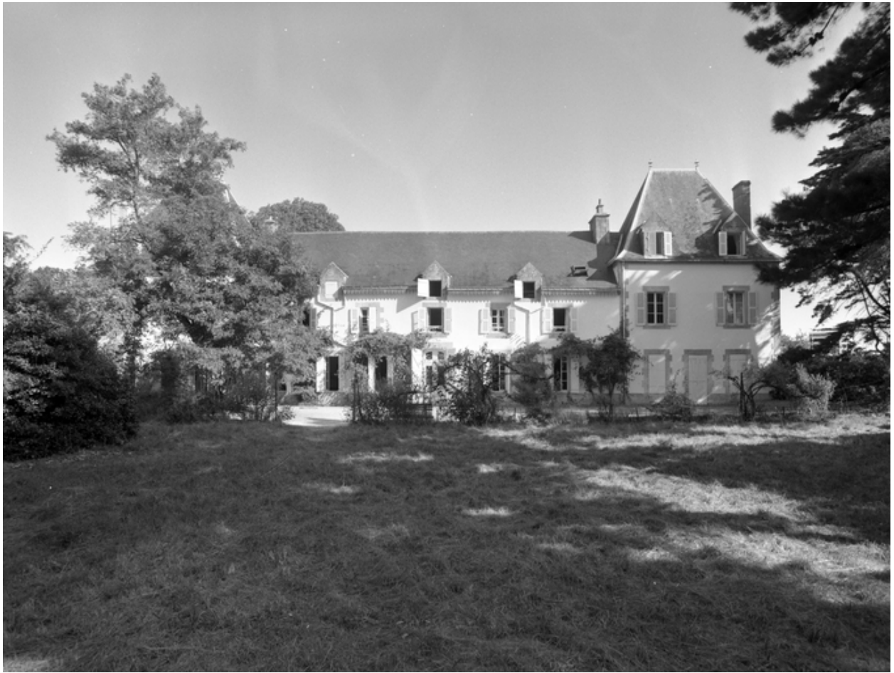
Vue générale sud
