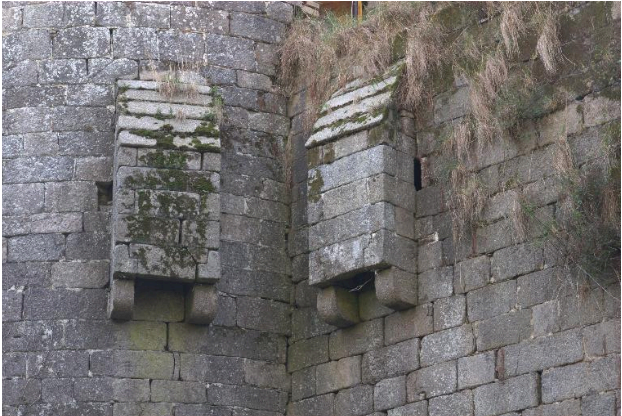
Vue de la tour orientale : deux des trois latrines en encorbellement implantées au nord
