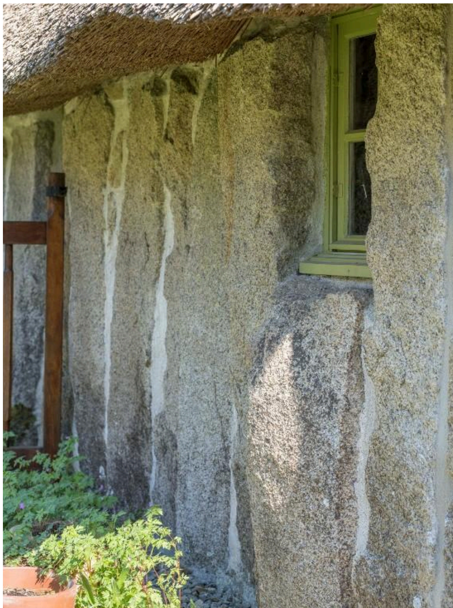
Vue de détail de l'élévation postérieure et d'une ouverture.
