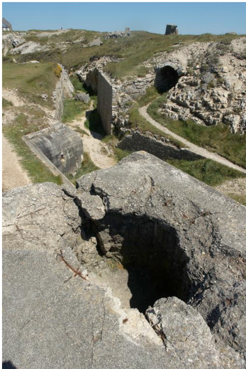
Vue du bunker - poste de direction de tir de type M162a : trace d'impact sur la dalle de couverture
