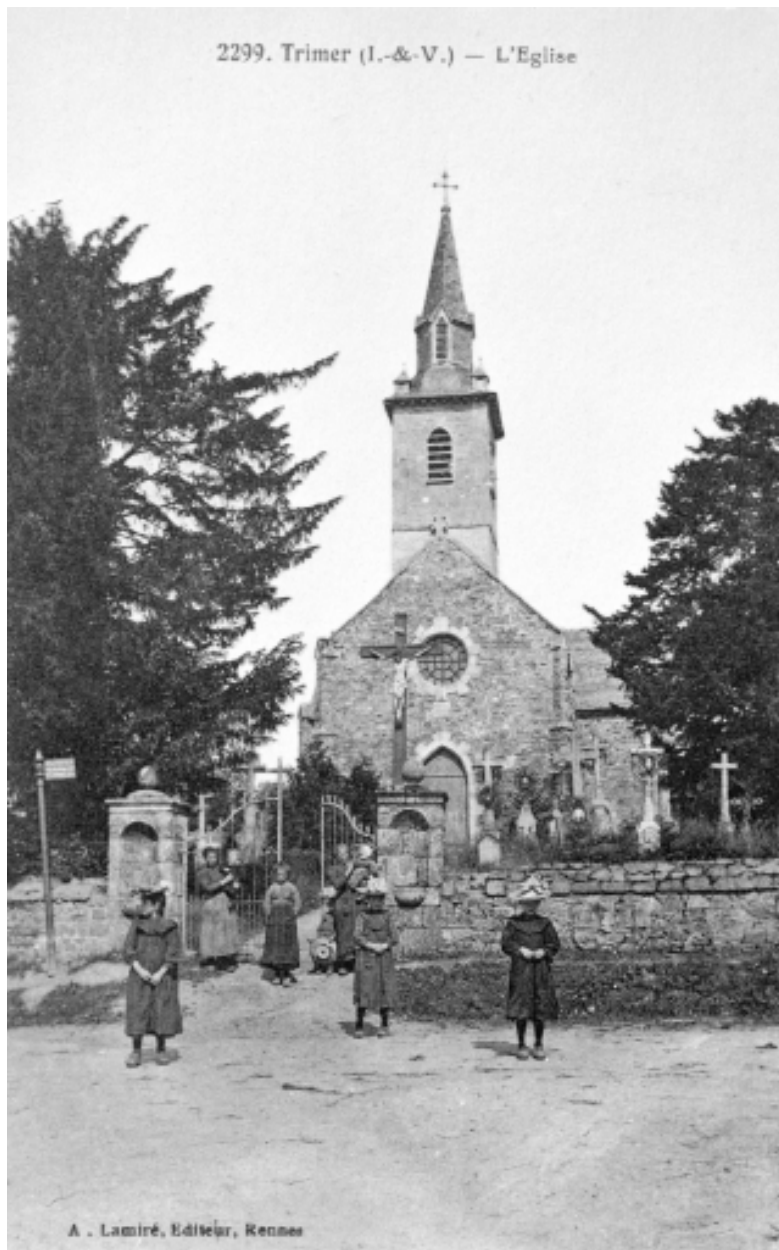
Elévation Ouest : vue générale (Carte postale ancienne, AD35 : 6Fi)
