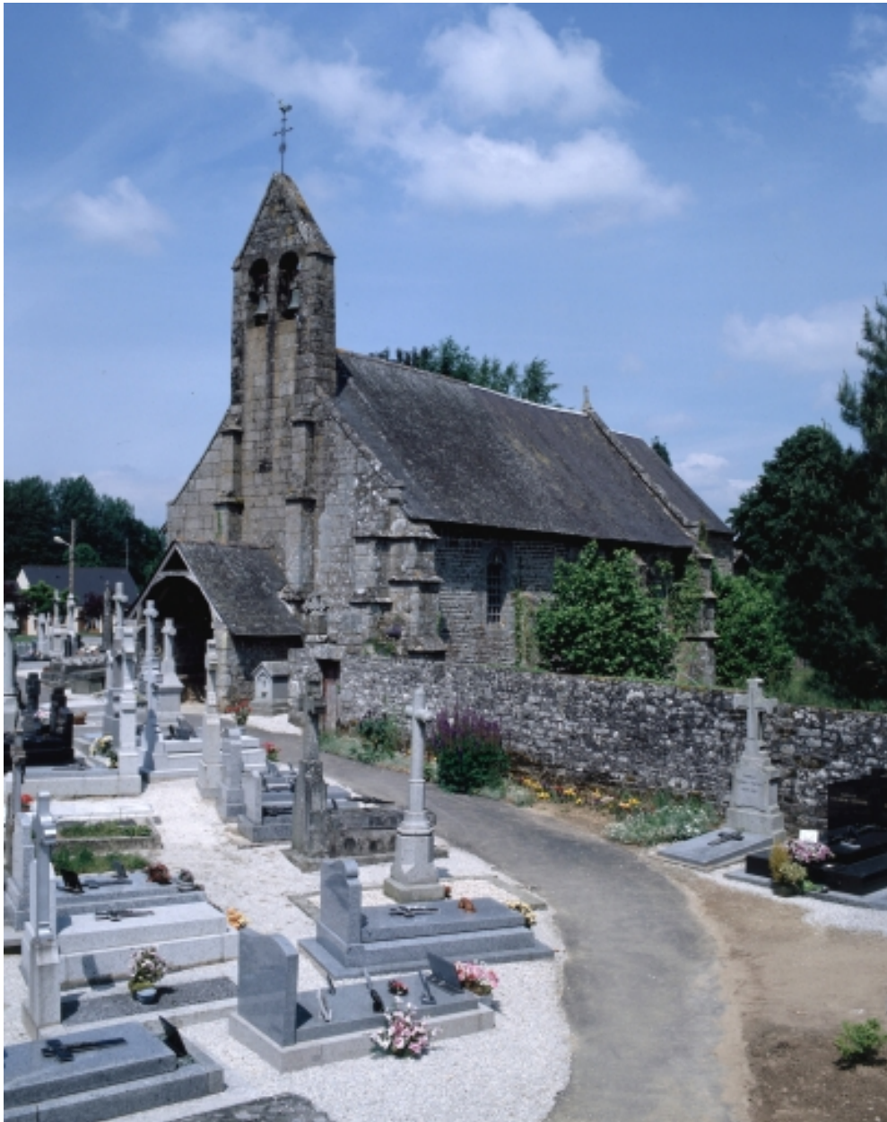
Elévation Sud-Ouest : vue générale
