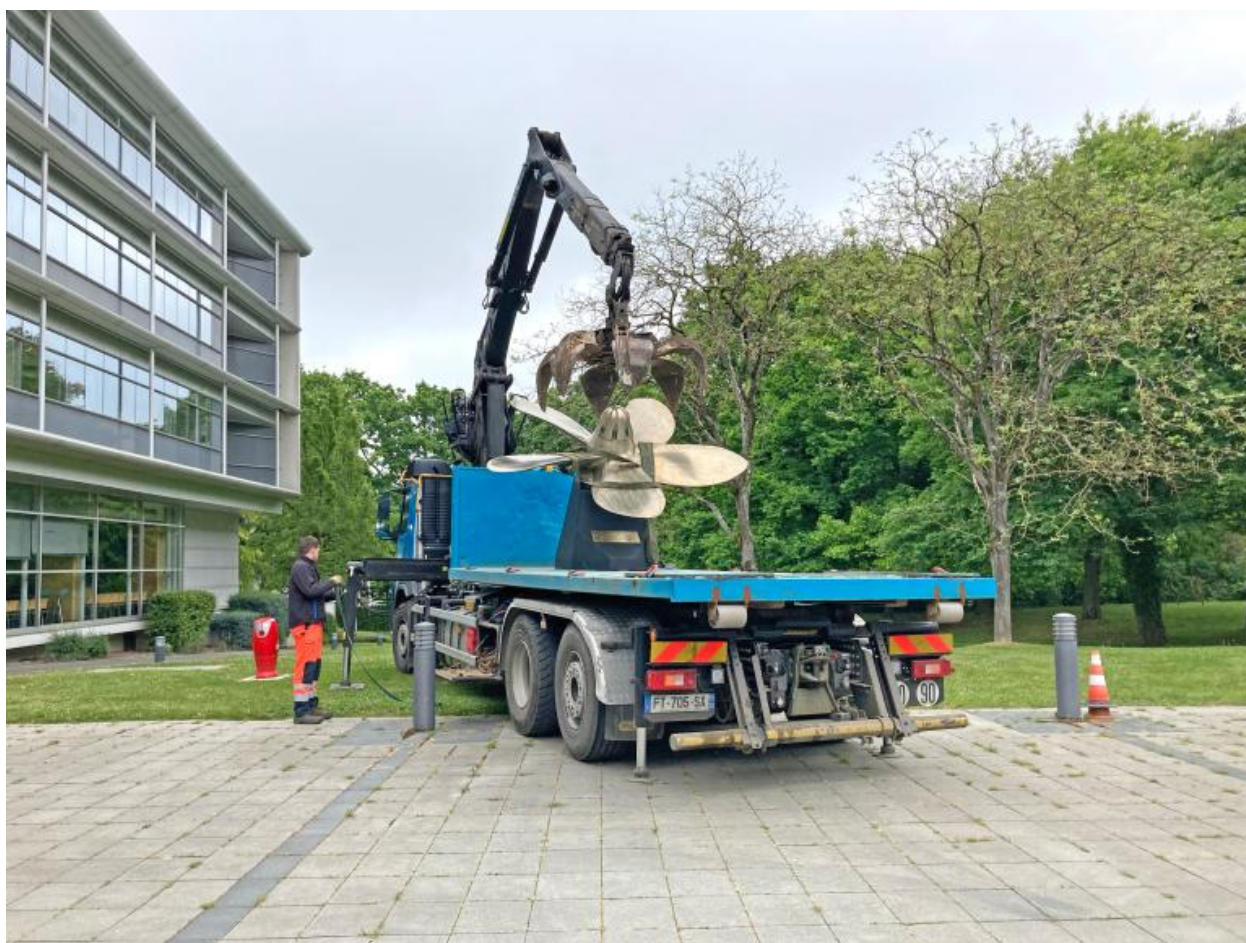
Vue de l'installation de l'hélice dans le Parc de l'Hôtel de Région par la société Navaleo, 6 mai 2022
