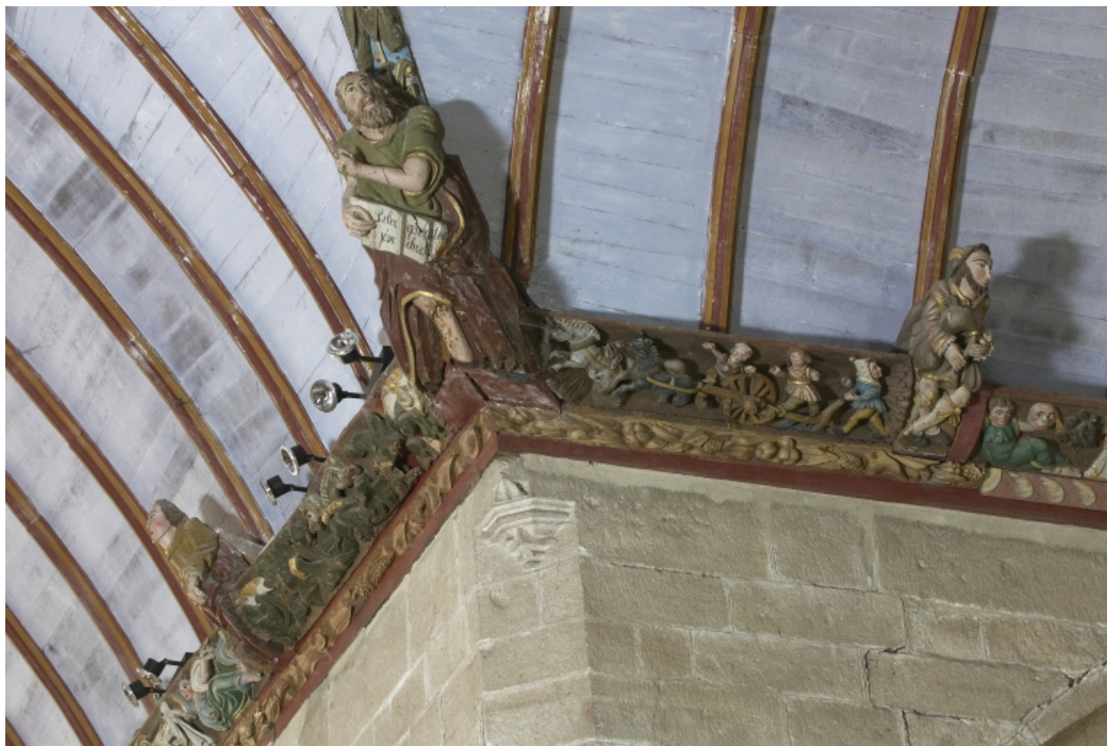
Intérieur, mur sud de la nef, détail de la sablière et du blochet
