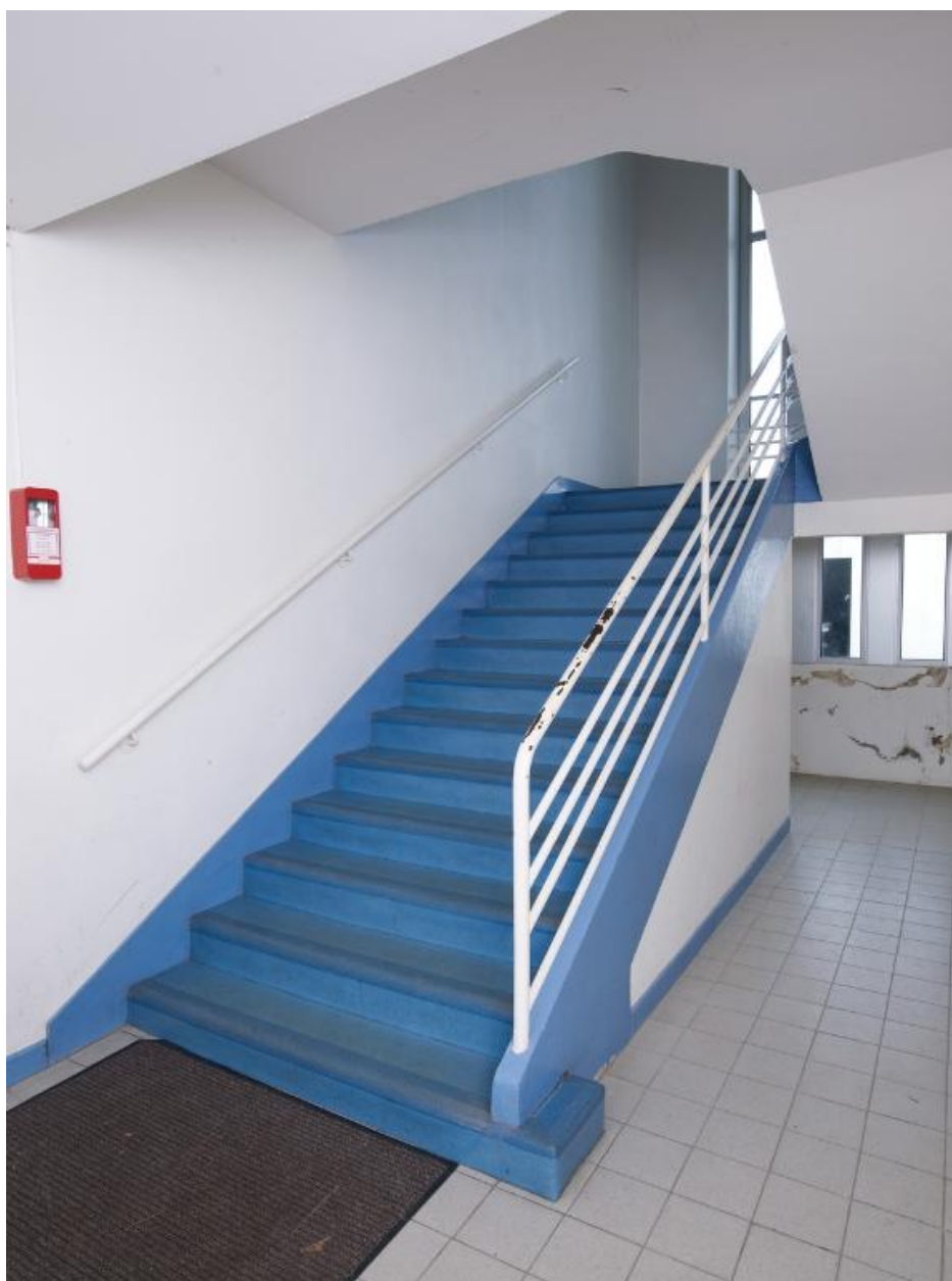
Escalier de l'internat : rez-de-chaussée.
